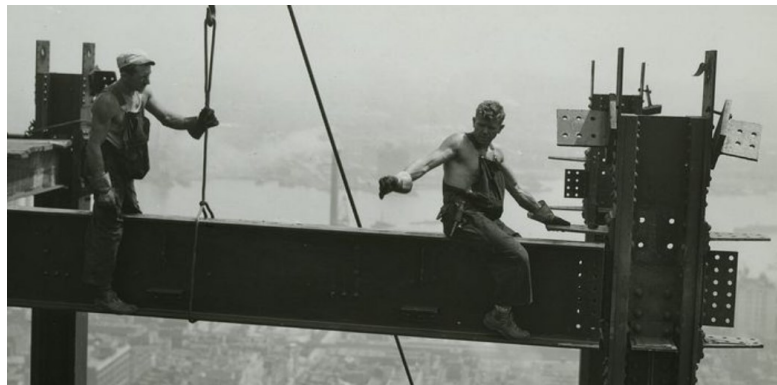
Figura 3 – Trabalhadores realizando conexão de viga com pilar no Empire State Building
