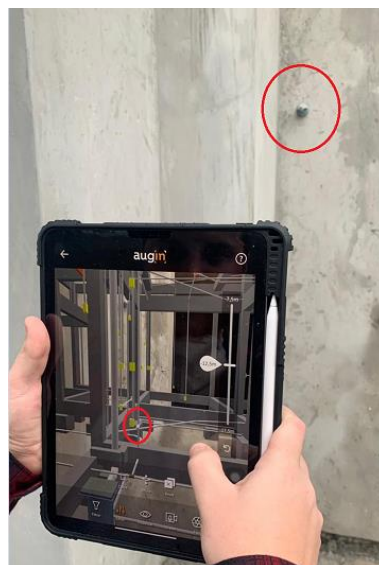
Figura 38: Diferença na altura do registro.
