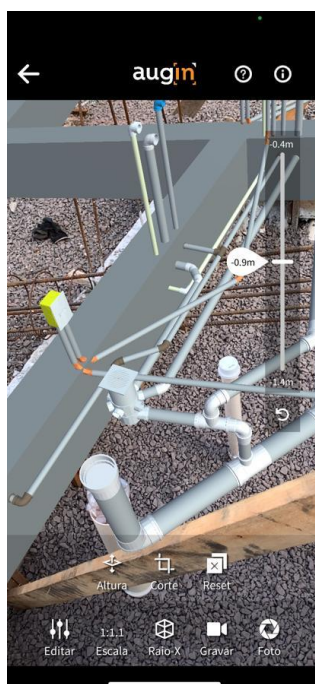
Figura 30: Instalações executadas conforme projeto.
