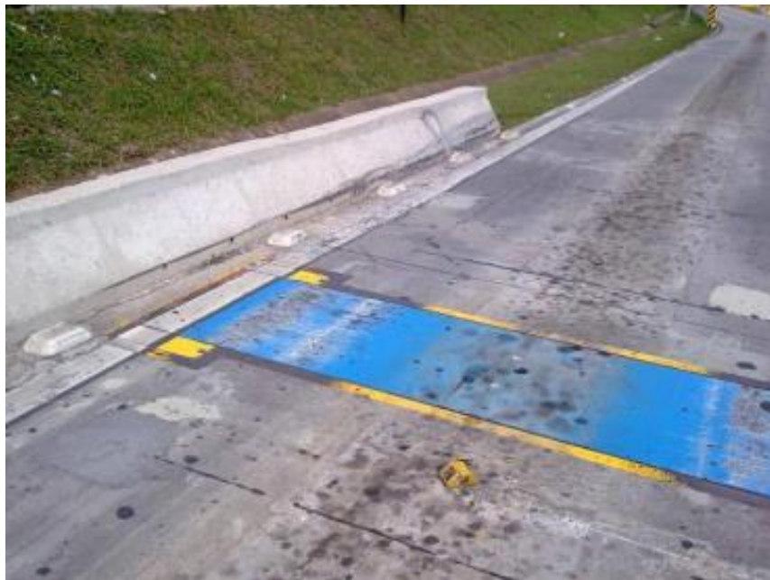
Figura 23 - Placa de pesagem de balança dinâmica e fixa
