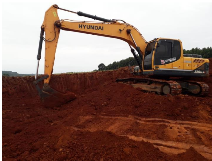
Figura 15 - Coleta das amostras de solo – Argila.
