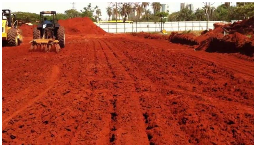
Figura 5 - Regularização de Subleito.
