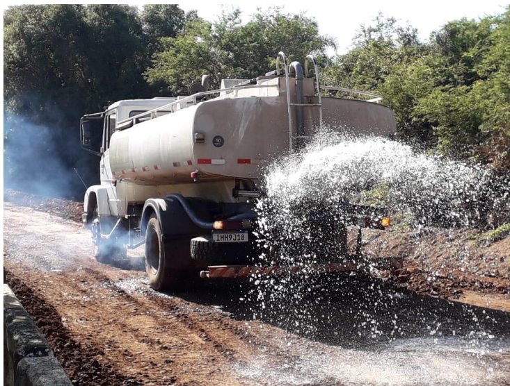
Figura 23 - Caminhão pipa molhando o solo com solução com aditivo
