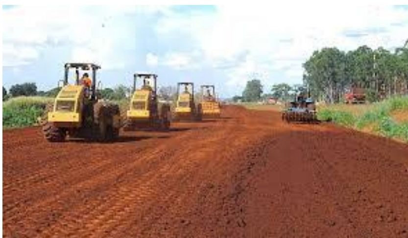
Figura 4 – Execução de Sub-base.
