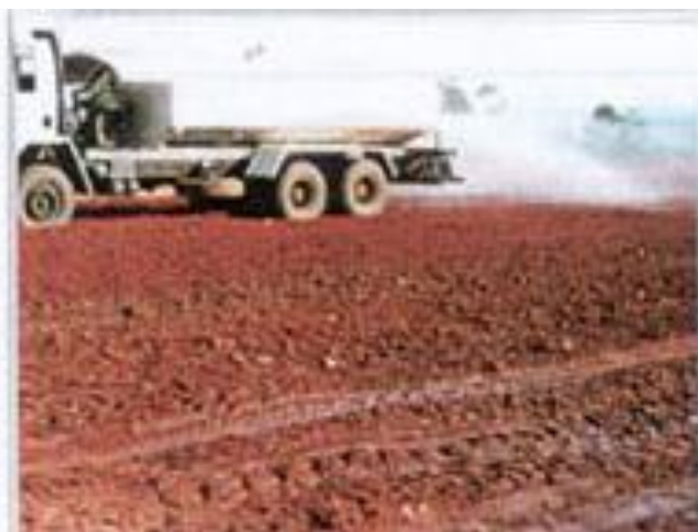
Figura 11 - Aplicação da Solução de Sulfato de Alumínio.
