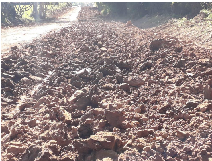
Figura 25 - Material solto após o processo de escarificação
