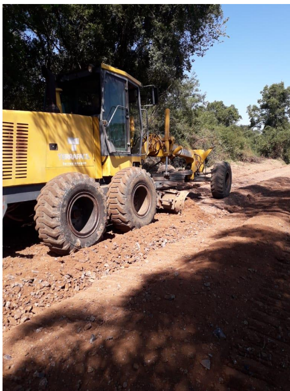
Figura 29 - Patrol motoniveladora regularizando o solo
