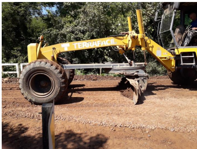
Figura 31 - Patrol motoniveladora regularizando o pavimento
