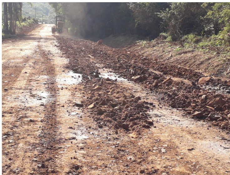
Figura 24 - Patrol motoniveladora escarificando o solo
