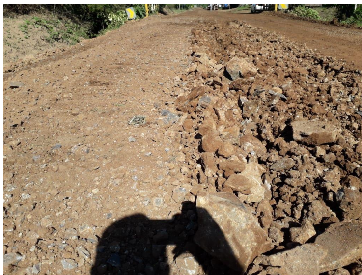
Figura 27 - Solo depois que passou pelo processo de moagem
