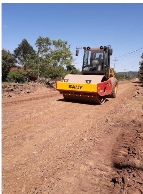
Figura 30 - Rolo compressor passando para compactar o solo.
