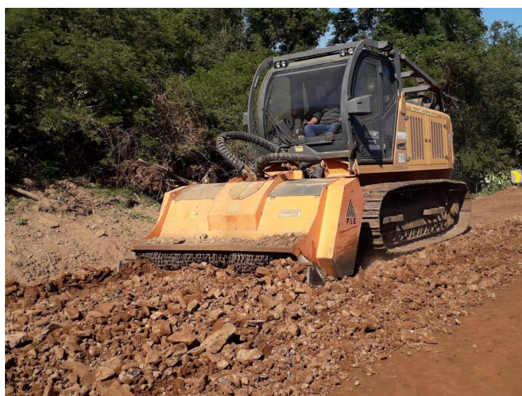
Figura 26 - Máquina PT-400 executando a moagem das pedras
