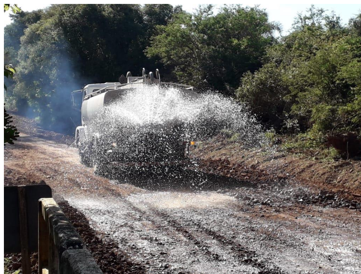
Figura 28 - Caminhão pipa molhando o solo com solução de aditivo.
