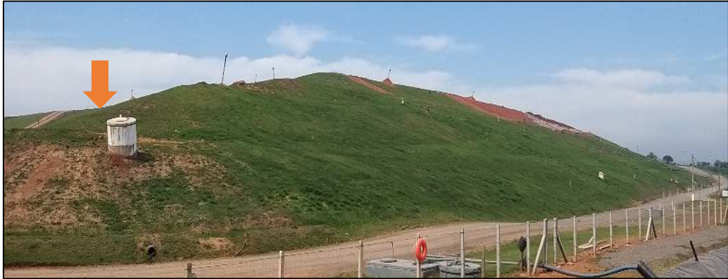
Figura 6 - PV 01 instalado no talude da Fase 1
