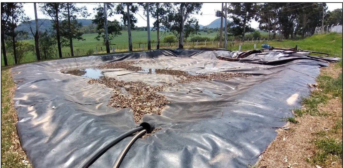
Figura 16 - Lagoa de rejeitos da Etapa 4
