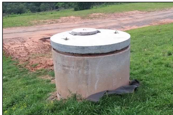
Figura 8 - Poço de Visita da Fase 3
