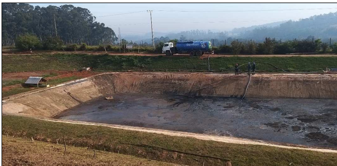
Figura 9 - Lagoa de acúmulo
