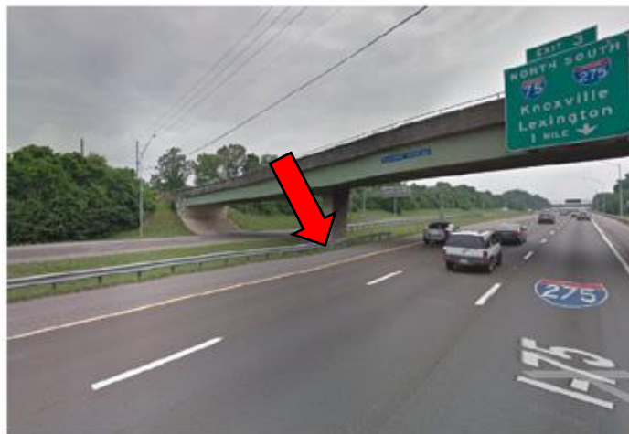
Figura 9 - Local onde foi encontrado o vazamento
