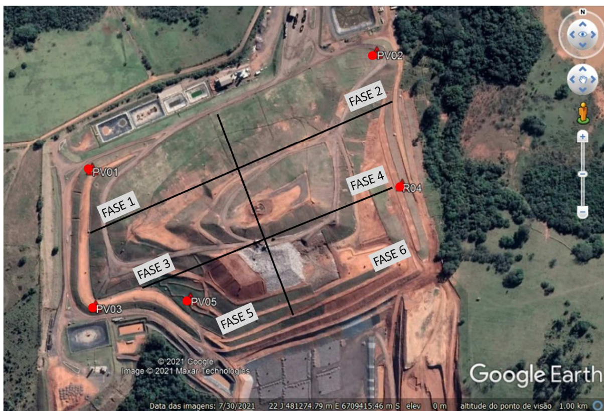
Figura 5 - Pontos de coleta de lixiviado nas diferentes fases do aterro
