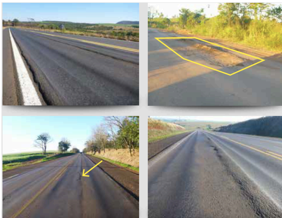
Figura 6 - Afundamento Plástico (AP)
