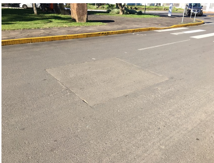
Fotografia 7 - Remendo bem executado
