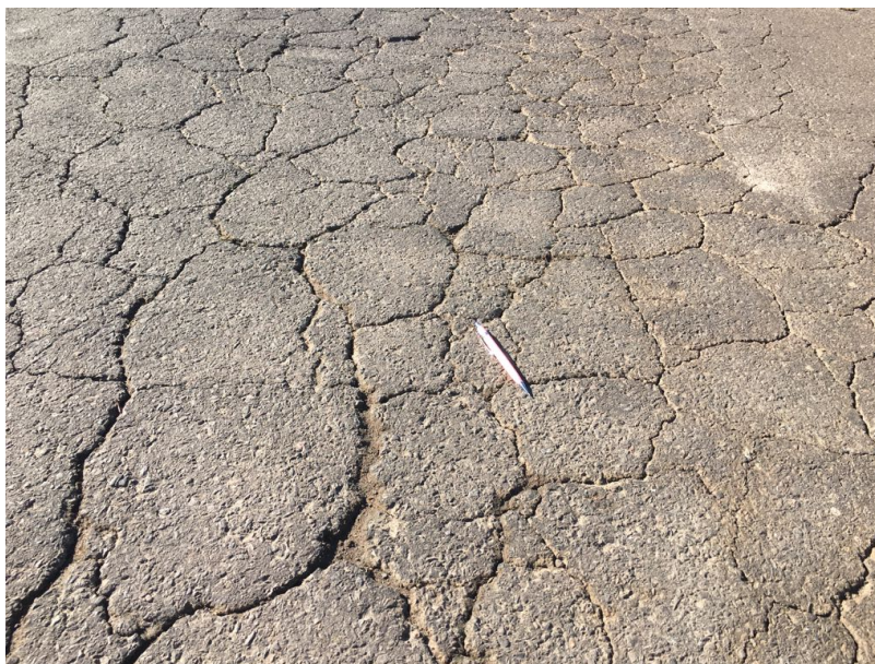
Fotografia 12 - Trinca Couro de Jacaré (TJ)
