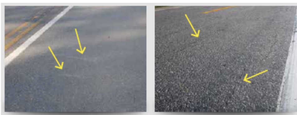
Figura 8 - Fissuras
