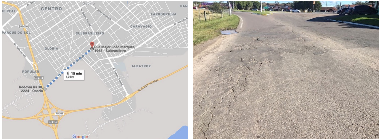
Figura 19 - Demarcação do trecho - Rua General Osório
