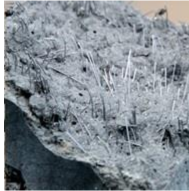
Figura 1 - Concreto reforçado com fibras curtas
