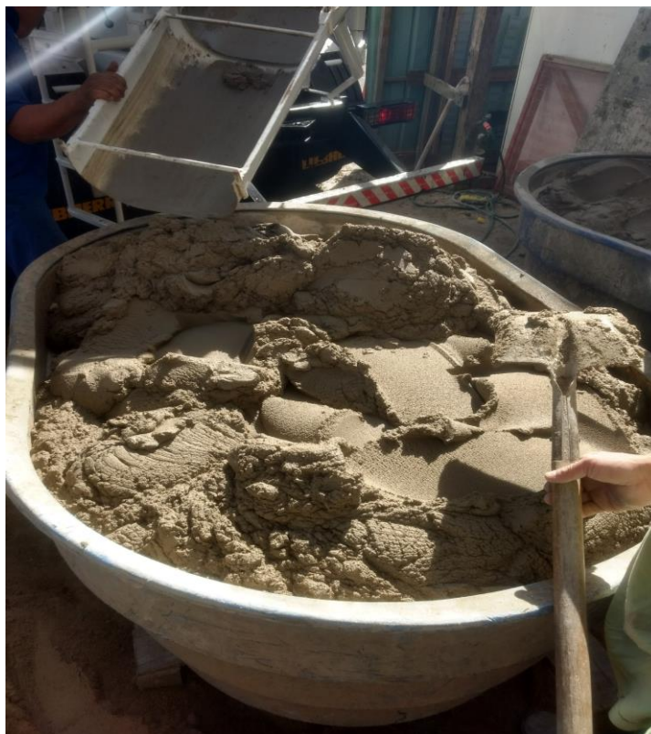
Figura 30 – Conferência da quantidade de argamassa entregue
