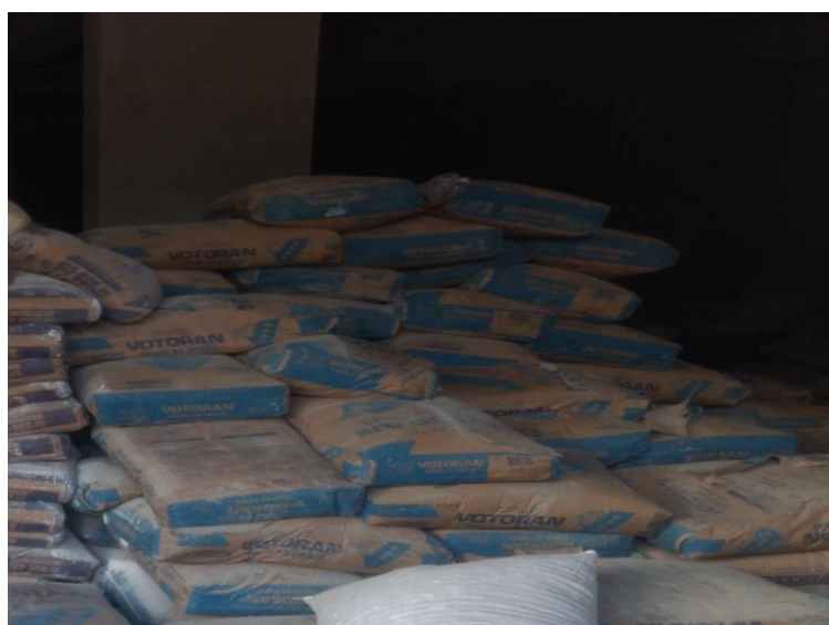
Figura 22 – Armazenagem de cimento da Obra 1
