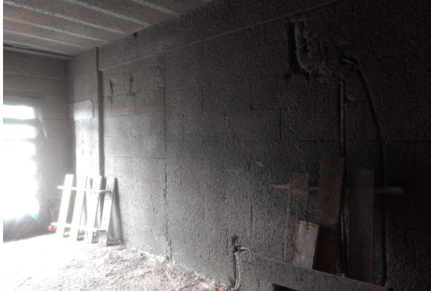
Figura 31 – Conferência do substrato após a execução do chapisco
