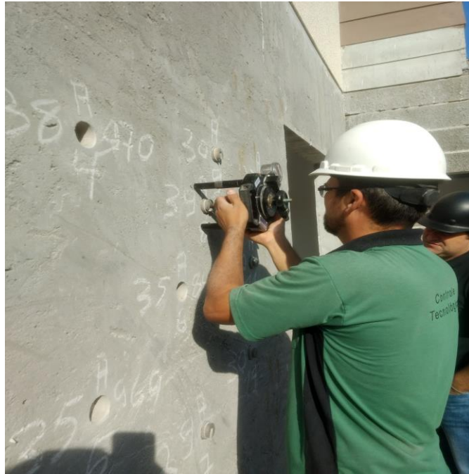
Figura 20 – Ensaio de tração Obra 01
