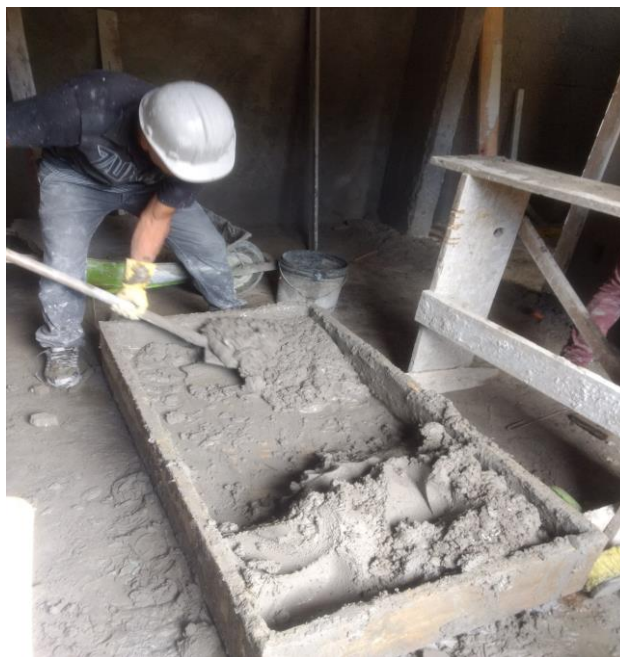
Figura 27 – Caixa de armazenamento de argamassa
