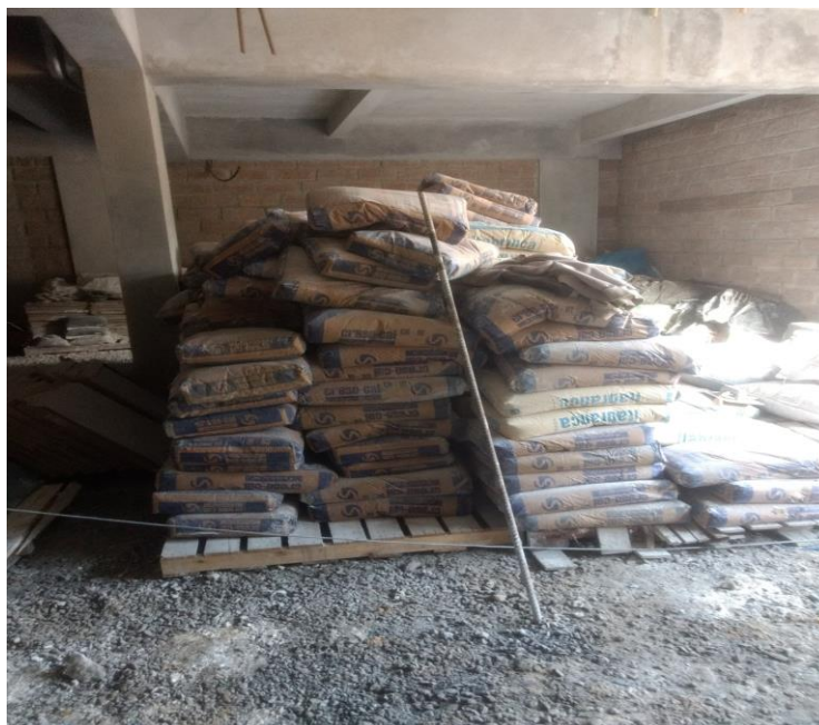
Figura 23 – Armazenagem de cal da Obra
