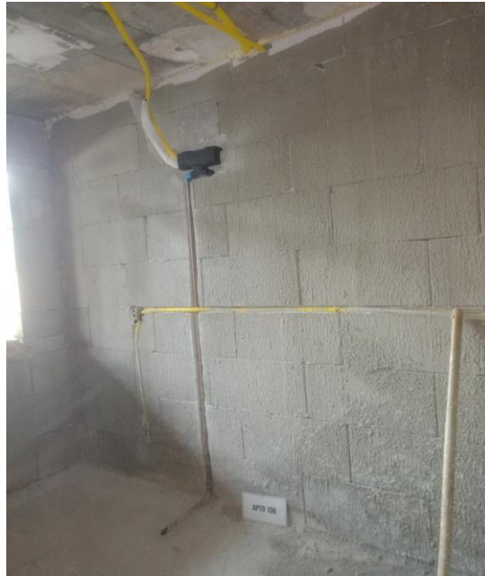
Figura 34 – Conferência do substrato após a execução do chapisco rolado
