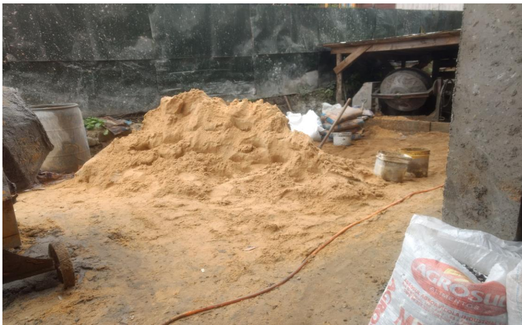
Figura 24 – Armazenagem de areia da Obra 1
