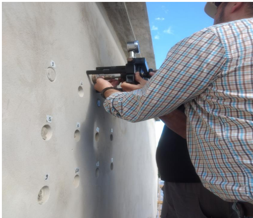
Figura 21 – Ensaio de tração Obra 02
