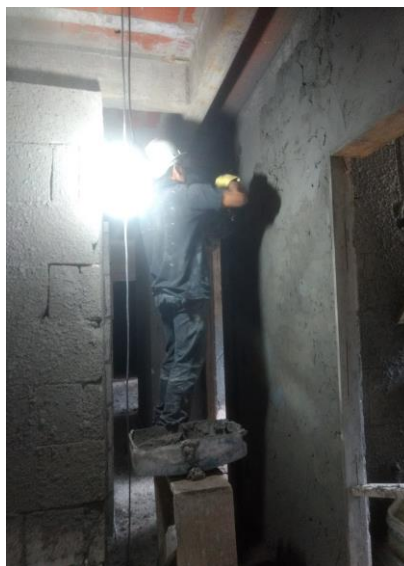
Figura 33 – Execução do emboço no substrato previamente chapiscado
