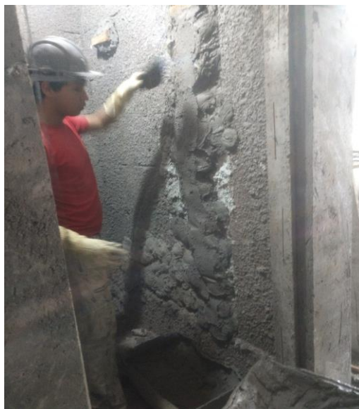
Figura 32 – Execução das mestras do emboço
