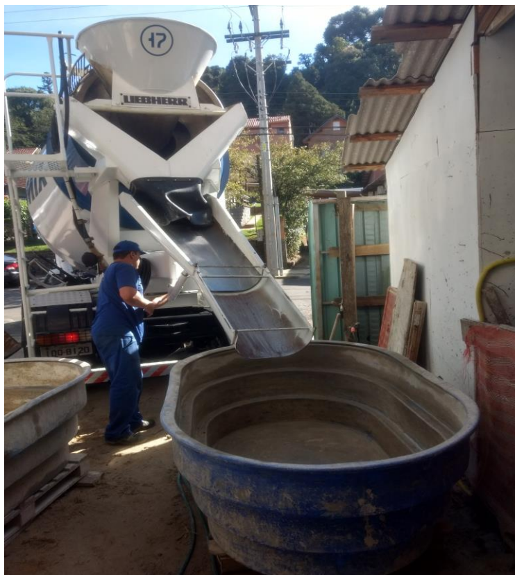
Figura 29 – Entrega da argamassa estabilizada
