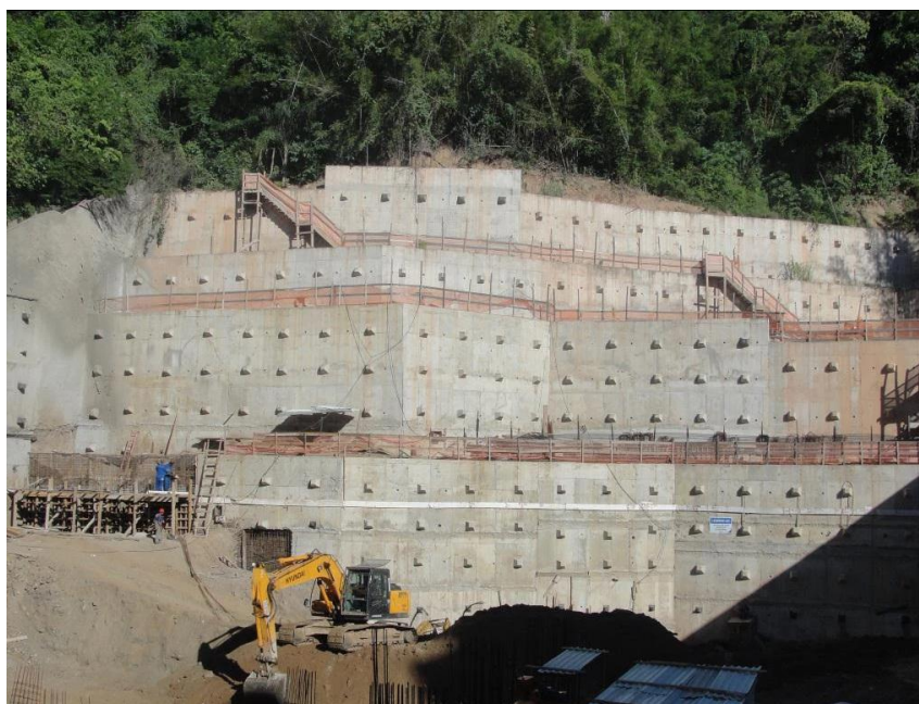
Figura 23 - Cortina atirantada na estabilização de um corte
