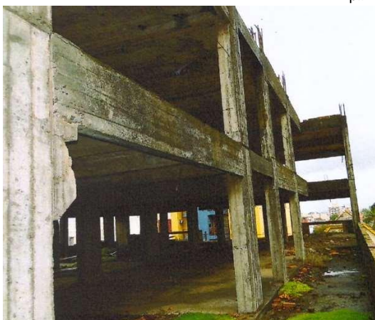
Figura 53 – Estrutura de concreto armado – “Bloco dos fundos” – “B pil ”
