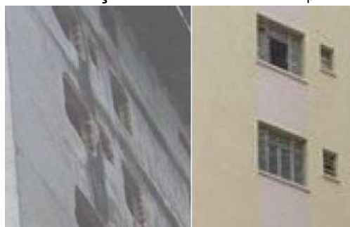
Figura 109 – Abertura de novos vãos e instalação de caixilhos – “E pil ”
