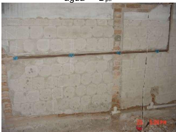
Figura 96 – Recuperação das tubulações de água – “D pil ”
