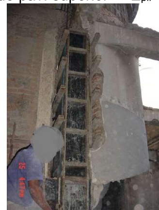
Figura 104 – Construção de pav. superior – “E pil ”
