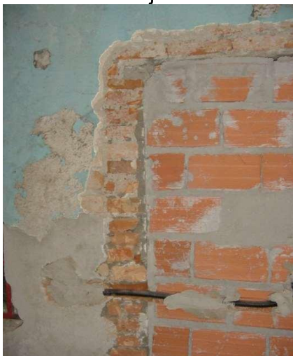
Figura 87 – Fechamento de porta interna em alvenaria de tijolo furado – “D pil ”
