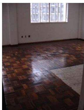
Figura 110 – Reaproveitamento de tacos nas salas e quartos – “E pil ”
