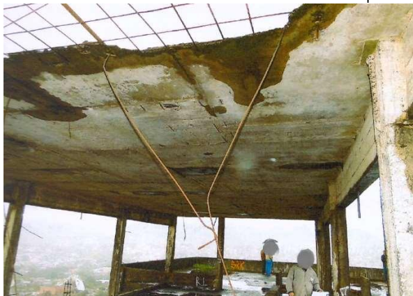
Figura 55 – Estrutura do salão de festas na cobertura – “Bloco frontal” – “B pil ”
