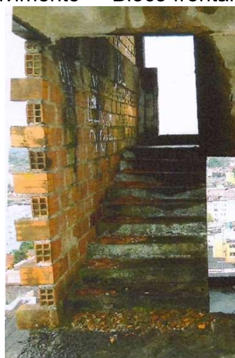
Figura 58 – Escada interligando o 15º ao 16º pavimento – “Bloco frontal” – “B pil ”
