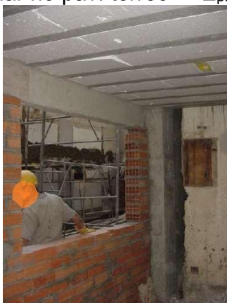
Figura 102 – Reforço de pilar no pav. térreo – “E pil ”
