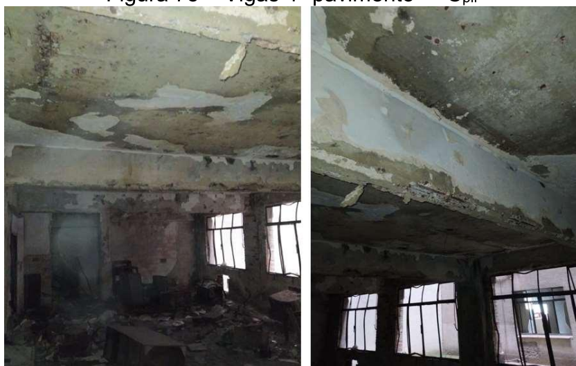
Figura 75 – Vigas 4º pavimento – “Cpil”
