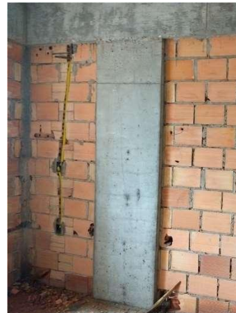
Figura 38 – Pilar da estrutura – “Apil”
