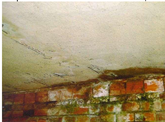
Figura 56 – Laje interna do 16º pavimento – “Bloco frontal” – “B pil ”
