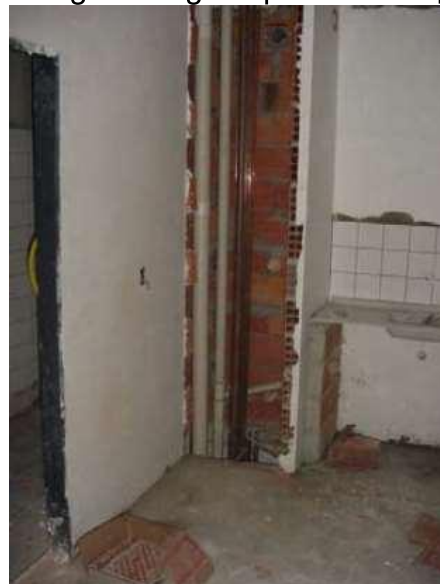
Figura 114 – Shafts para direcionar rede de esgoto e águas pluviais – “E pii ”
