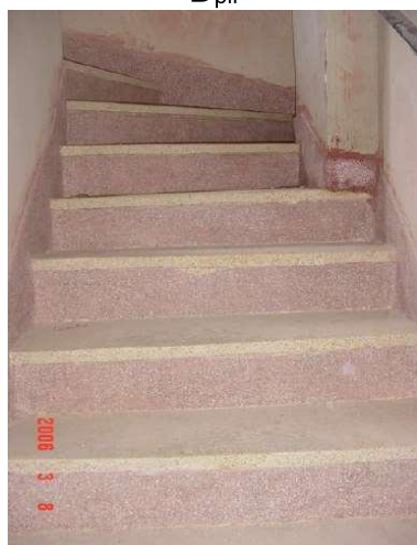
Figura 91 – Reparo no granilite das escadas – “D pil ”
