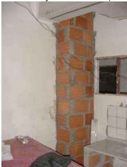
Figura 113 – Shafts para direcionar nova canalização interna – “E pii ”
