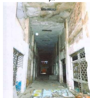
Figura 68 – Vista parcial do corredor central do térreo – “Bloco frontal” – “B pil ”
