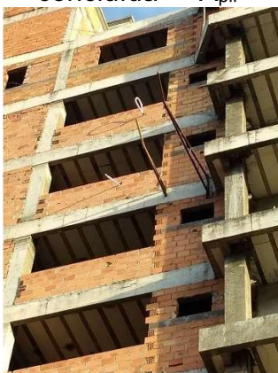
Figura 41 – Alvenaria concluída – “A pil ”
