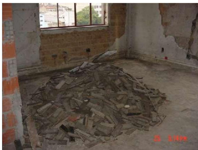
Figura 107 – Execução e recuperação de alvenaria – “Epil”
