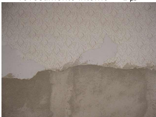
Figura 89 – Recuperação de revestimento interno – “D pil ”
