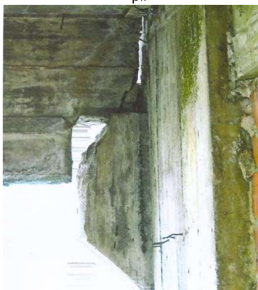
Figura 51 – Ligação entre o “Bloco frontal” e o “Bloco dos fundos” – “B pil ”
