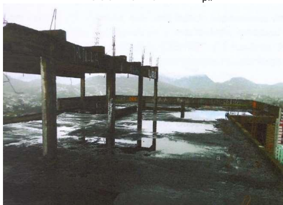
Figura 49 – Vista parcial da cobertura do “Bloco frontal” – “B pil ”
