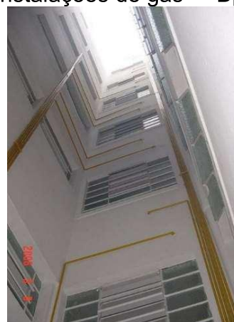
Figura 97 – Prumadas para instalações de gás – “D pil ”
