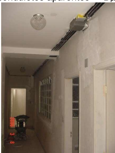
Figura 94 – Eletrodutos rígidos e condutores aparentes – “Dpil”
