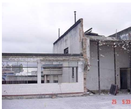
Figura 103 – Demolição de parte da cobertura – “E pil ”
