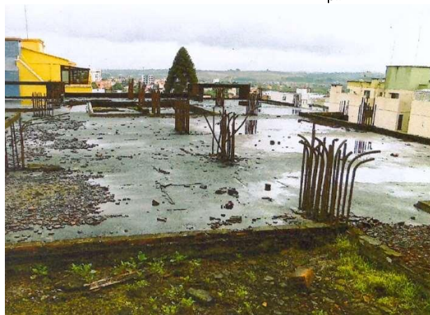
Figura 54 – Último pavimento executado – “Bloco dos fundos” – “B pil ”
