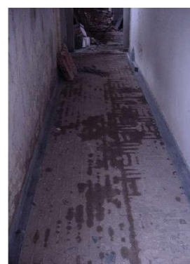
Figura 111 – Remoção de tacos nos corredores – “E pil ”
