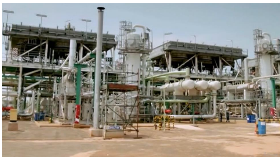
Figura 31 – Imagem sobre parque industrial
