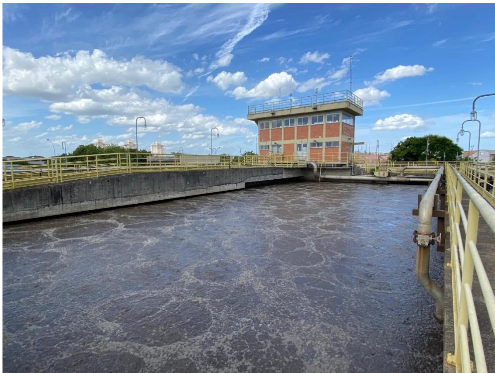
Figura 11 – Reator de lodos ativados (ponto de coleta “P2-Verde”)
