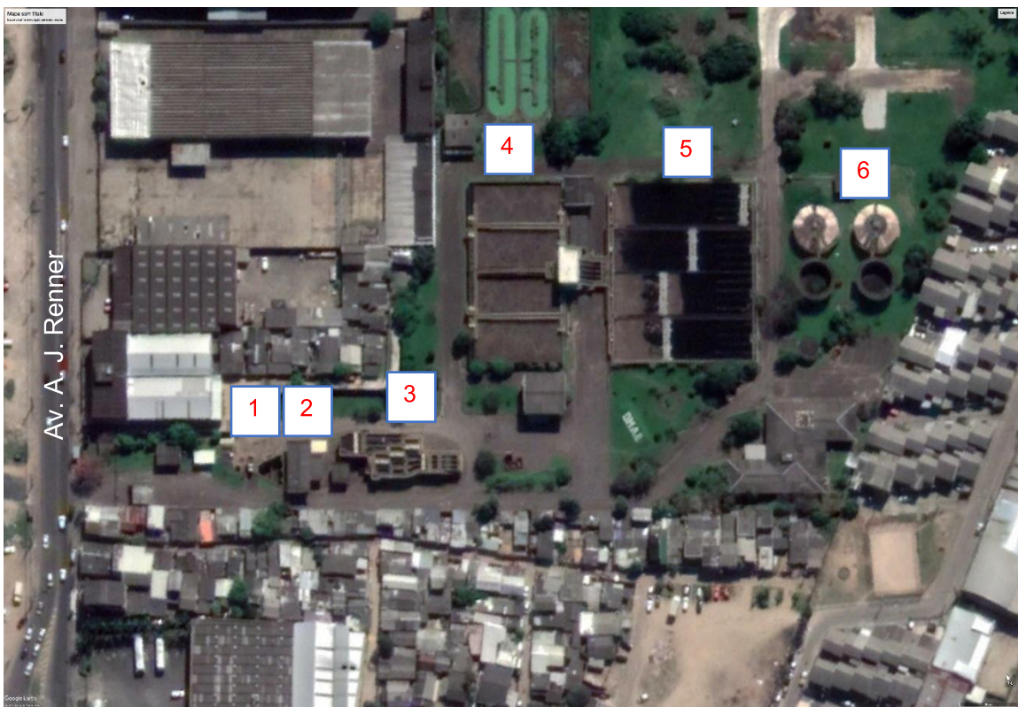
Figura 9 – Implantação da ETE São João-Navegantes
