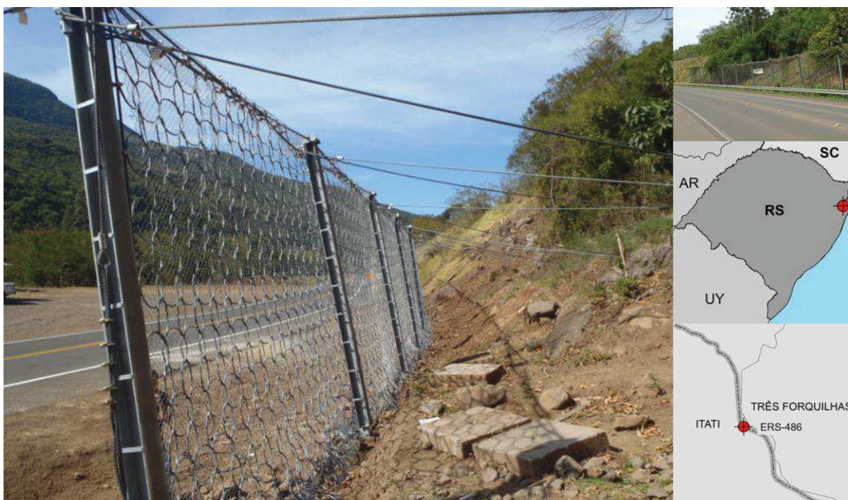
Figura 20: Sistema instalado na Rota do Sol
