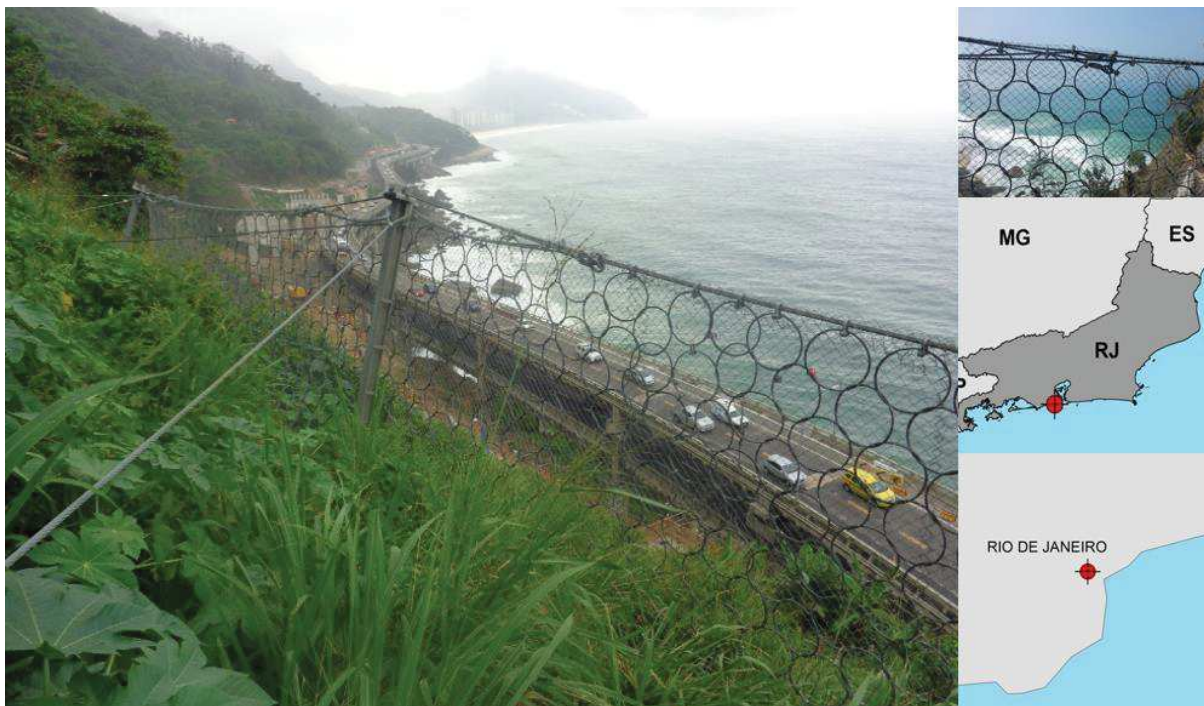
Figura 21: Mapa de localização e sistema instalado Emboque do Túnel do Pepino
