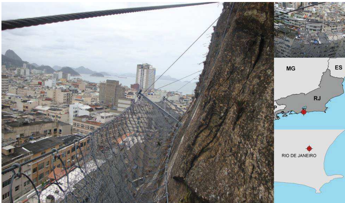
Figura 22: Mapa de localização e sistema instalado no Morro Pavão-Pavãozinho
