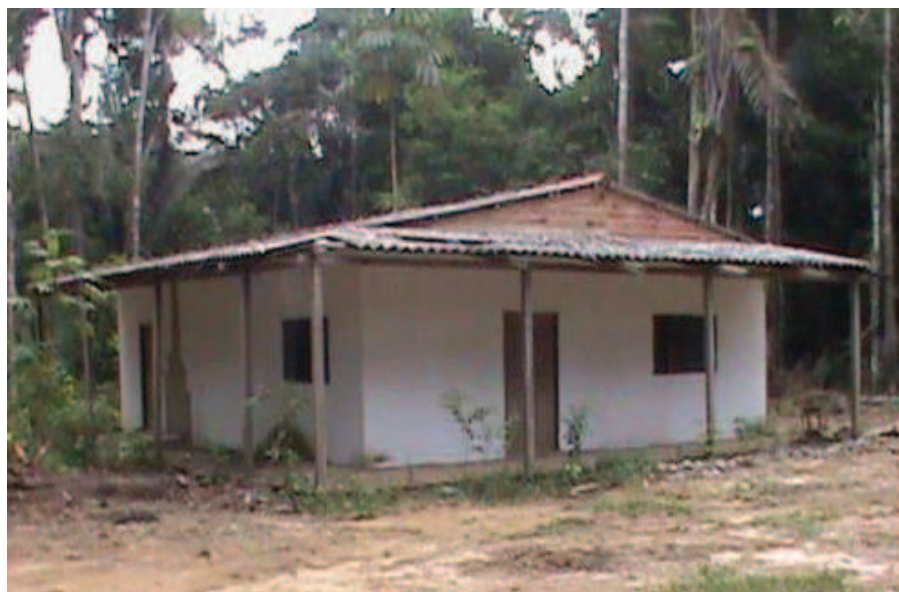
Imagens 35 e 36: interior do Parque Natural e o Polo em construção. Fonte: arquivo da autora.
