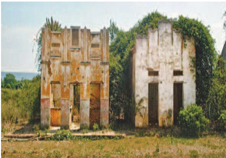
Foto 02: Ruínas de casas da Fazenda Cococi, na cidade de Parambu
