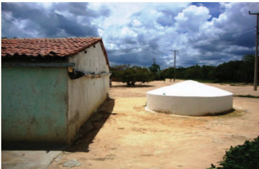
Foto 06: Cisterna de placa
