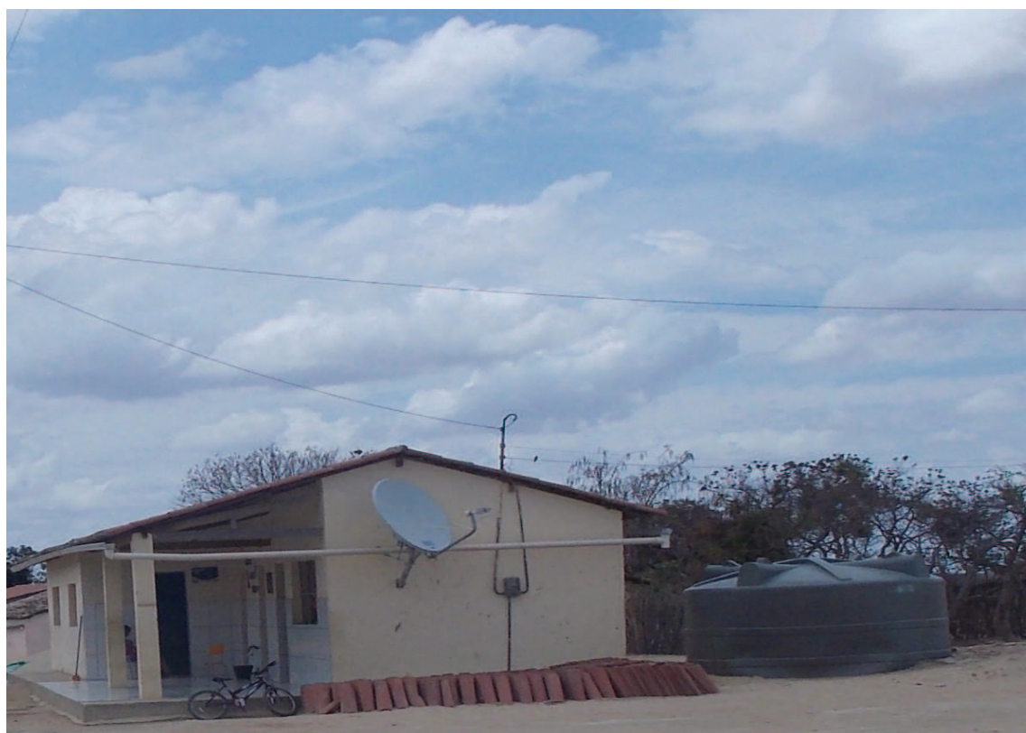
Foto 13: Cisterna de polietileno Fonte: José Willame Felipe Alves
