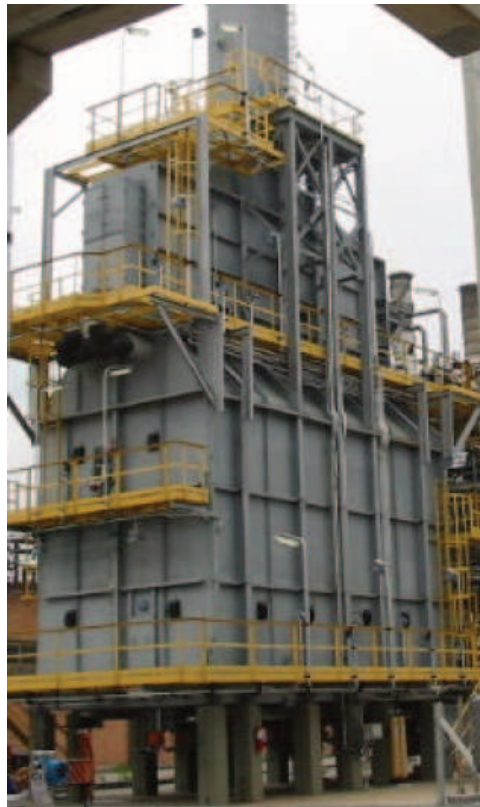
Figura 2.1: Foto externa de um forno de unidade de destilação atmosférica de petróleo.
