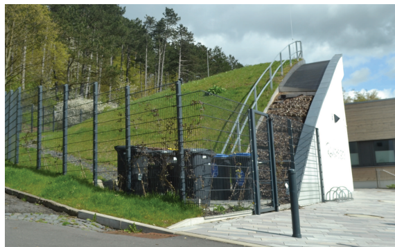
Figura 21 - Exemplos de telhados verdes
