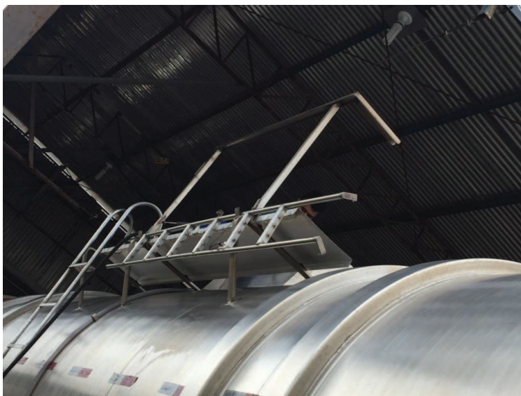
Figura 2 - Montagem do guarda-corpo
