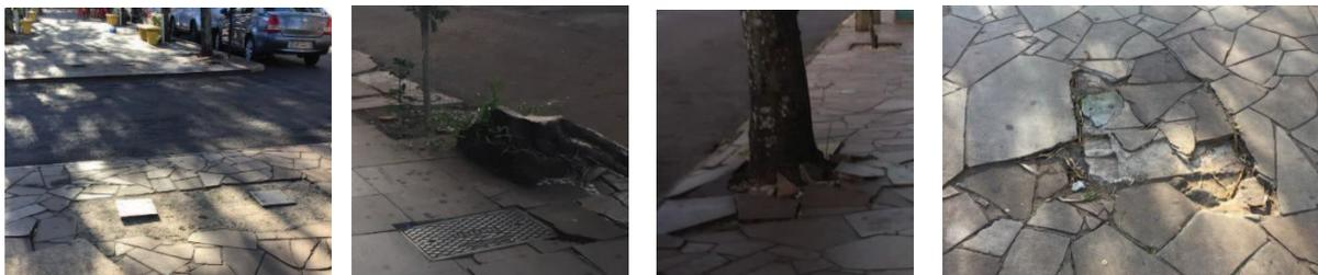
Pavimentação sem manutenção e inadequada para aspectos de acessibilidade.
