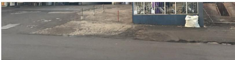
Inclinação inadequada, toda extensão da calçada em forma de rampa
