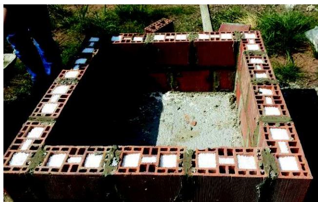
Figura 25 - Construção protótipo com preenchimento de esferas de EPS (P2)
