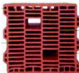
Figura 8 - alveolar brick (bloco alveolar) desenvolvido para ampliar o desempenho térmico e acústico das alvenarias
