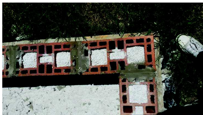
Figura 26 - Construção protótipo com preenchimento de perlita expandida (P3)
