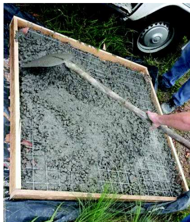
Figura 23 - Construção das lajes
