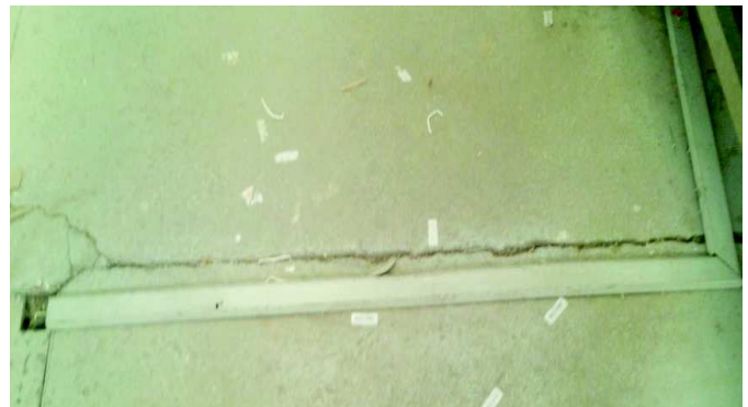
Figura 12 – Instalações elétricas (depois).
