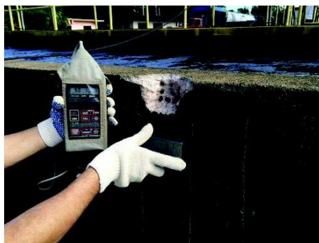
Figura 6: utilização de pacômetro para detecção das armaduras
