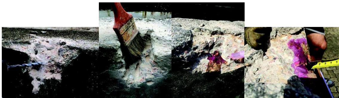
Figura 4: sequência para verificação da profundidade de carbonatação
