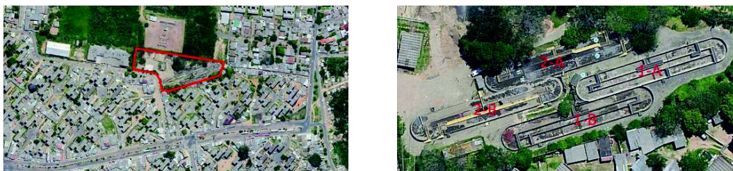
Figura 2: localização da ETE Rubem Berta e definição dos tanques de aeração
