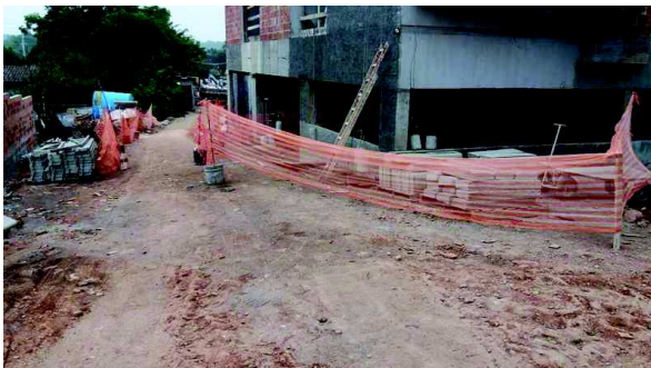
Fotografia 01 – Limitação da área de trabalho da plataforma (O.3)
