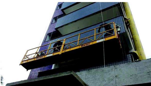
Fotografia 05 – Andaime em ótimas condições (O.2)
