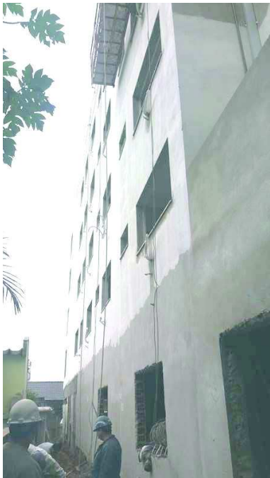
Fotografia 03 – Equipe trabalhando abaixo da plataforma (O.4)
