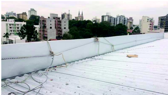
Fotografia 08 – Pontos de fixação do andaime (O.4)
