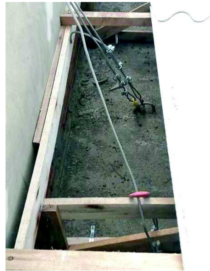
Fotografia 07 – Pontos de fixação do andaime (O.1)
