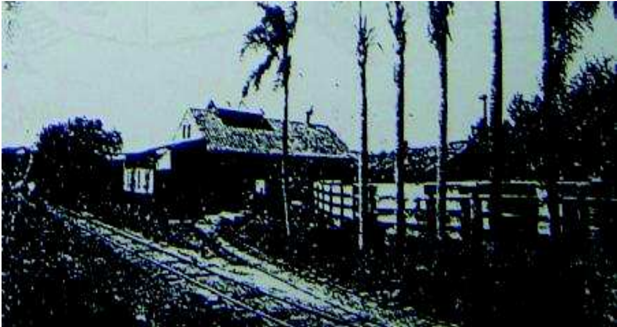
Figura 04 – Estação Férrea do Matadouro Kroeff ou Parada Kroeff – Novo Hamburgo
