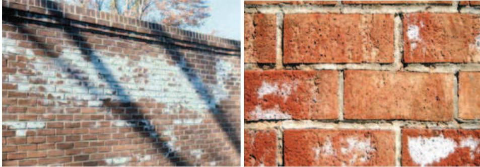
**Figura 2** - Eflorescência em alvenaria.
