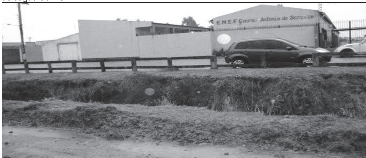
Figura 16. Detalhe do canal de esgoto na rua em frente à EMEF General Antônio de Sampaio de Jaguarão-RS
