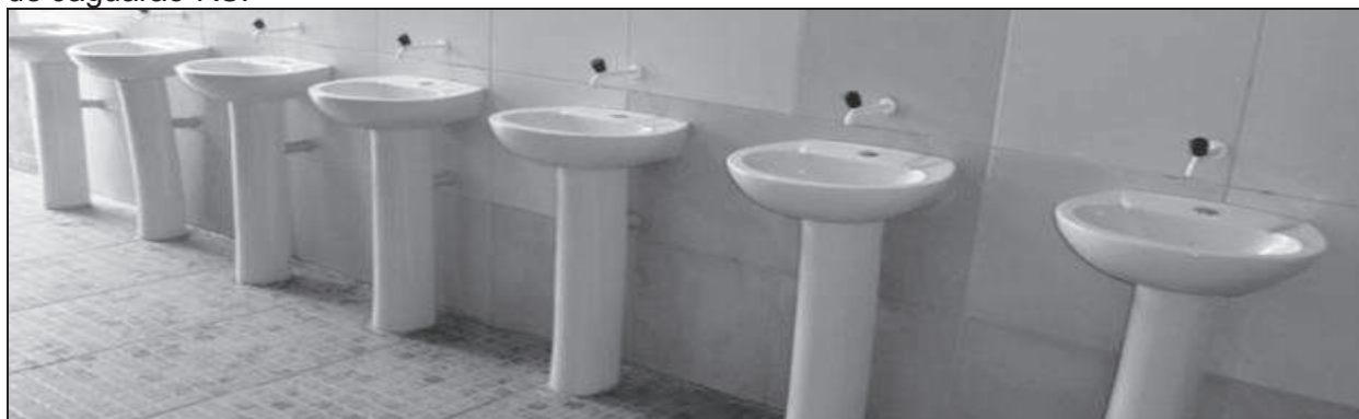
Figura 20. Instalações destinadas à prática de escovação dos dentes na EMEF Marcílio Dias de Jaguarão-RS.
