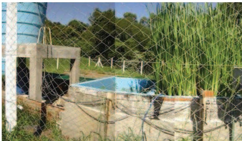
Figura 12: Sistema de distribuição do efluente a ser tratado.
