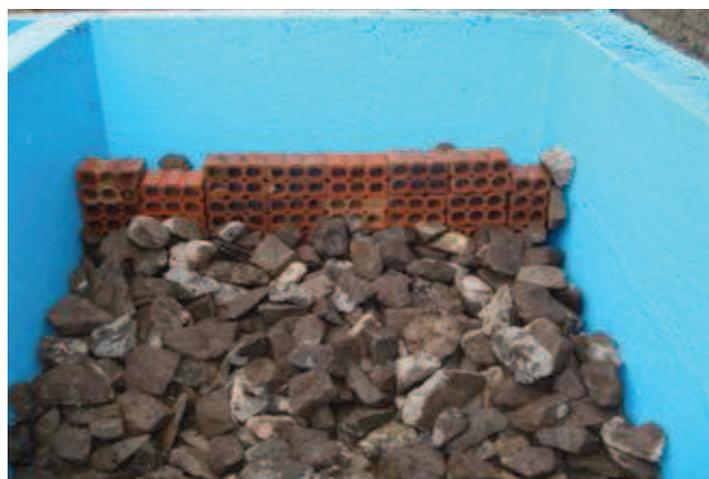
Figura 7: Etapa 3a de construção dos *wetlands*: colocação das pedras (brita 5) e detalhe da distribuição horizontal de fluxo nos *wetlands* horizontais.
