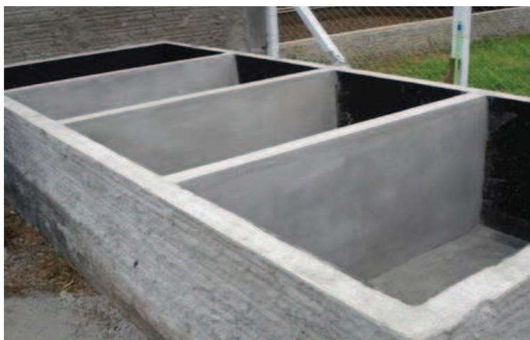
Figura 5: Etapa 1 de construção dos *wetlands*: alvenaria e reboco
