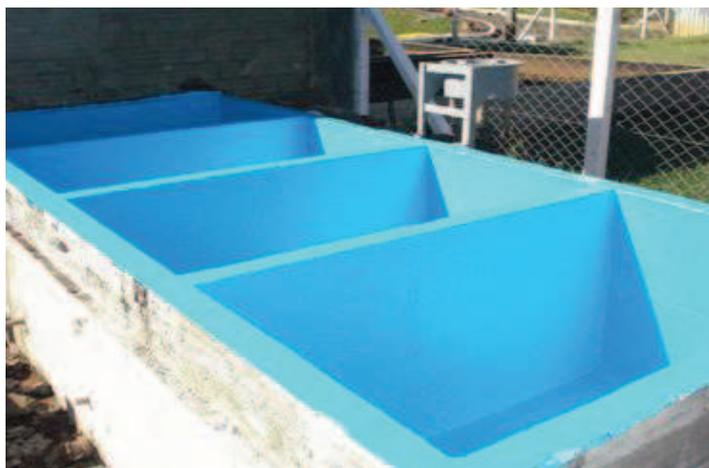
Figura 6: Etapa 2 de construção dos *wetlands*: revestimento em fibra de vidro
