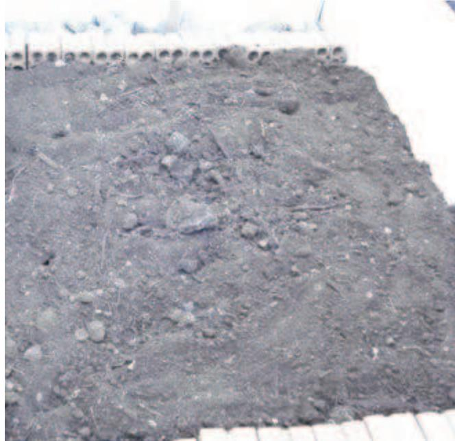
Figura 9: Etapa 4 de construção dos *wetlands*: colocação do solo sobre o leito de britas.
