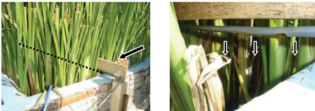
Figura 11: Etapa 5b de construção dos *wetlands*: sistema de distribuição superior nos *wetlands* verticais.
