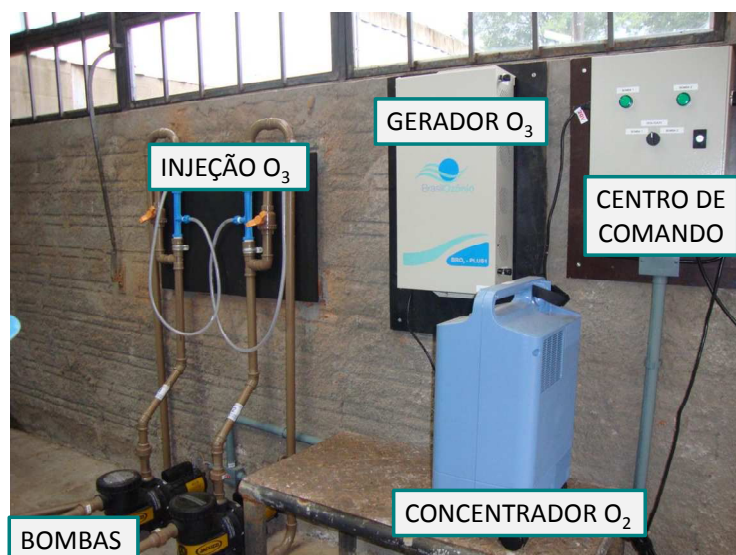
Figura 11: Sistema de Geração e Transferência de Ozônio BRO3-PLUS
