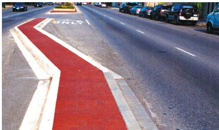
Figura 8 - Passeio central composto por meios fios brancos e tijolos vermelhos, Estados Unidos.
