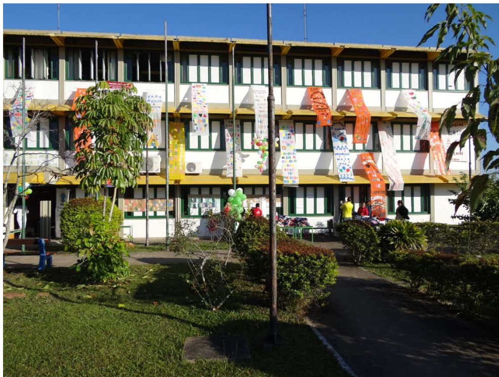
Figura 7- Prédio principal tem salas em três pavimentos
