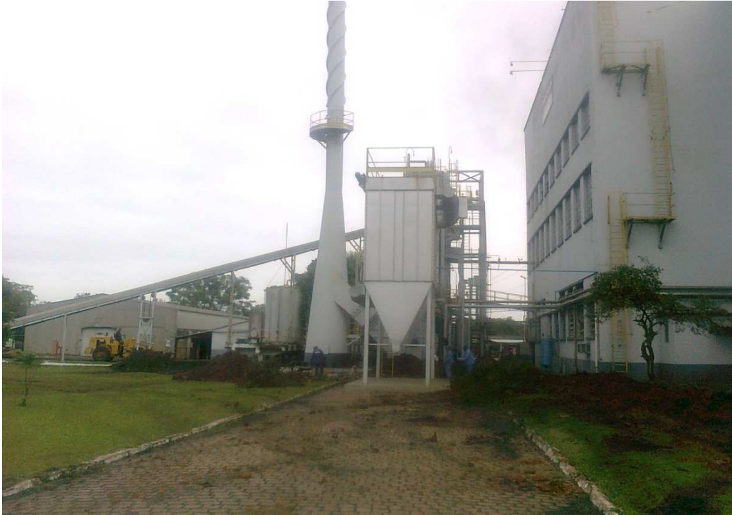
Figura 43 - Vista externa da usina de São Jerônimo – RS
