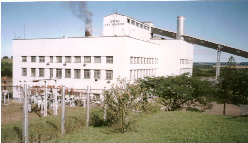
Figura 41 - Vista geral da Usina de São Jerônimo - RS
