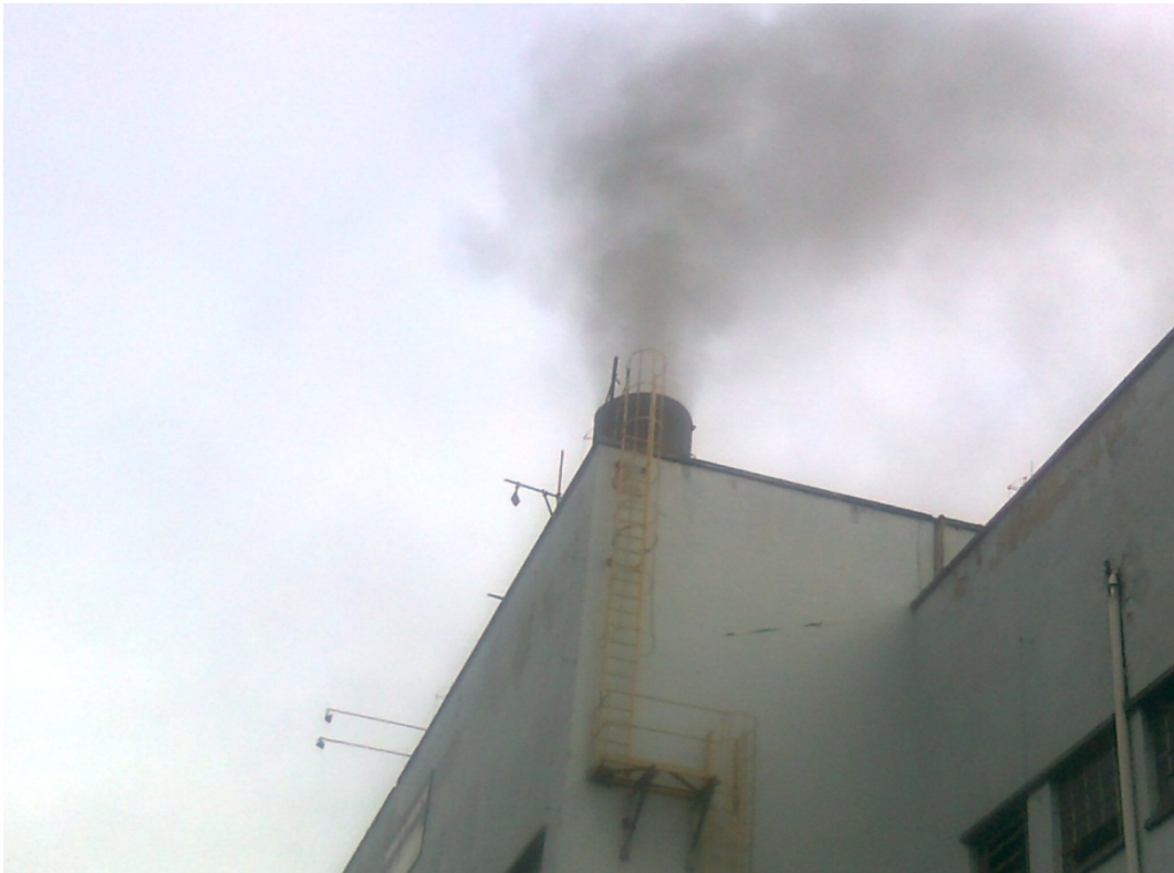
Figura 44 - Vista da saída da queima dos gases
