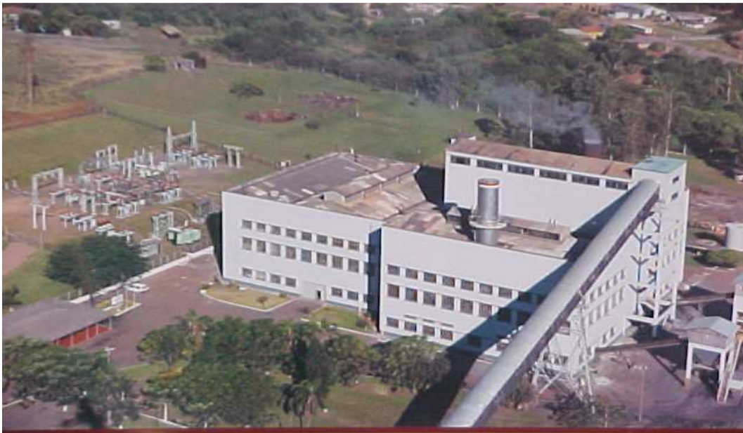
Figura 42 - Vista área dinâmica da Usina
