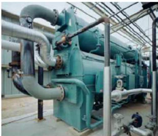
Figura 2.13: Chiller de absorção de queima indireta de água-brometo de lítio
