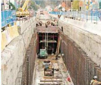
● Via sistema cut and cover (cortar e cobrir) ou vala comum a céu aberto, com escavações rentes à superfície (em túnel raso), em trechos curtos por vez, para diminuir o impacto no trânsito (acima, um exemplo)
