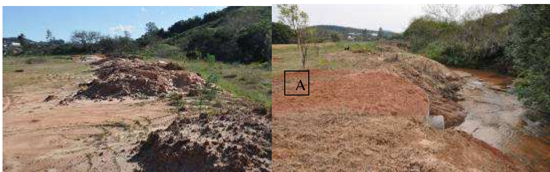
Figura 19 - Barreira de contenção (esq.) - Margem do arroio (dir.)
