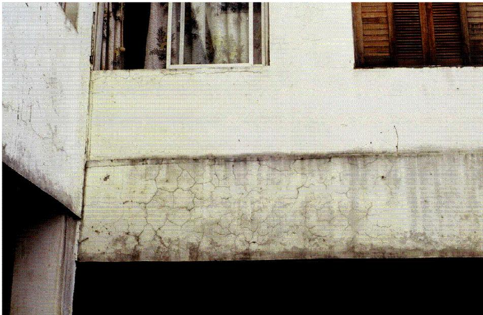
**Figura 2 – Fissuras produzidas por retração.**
