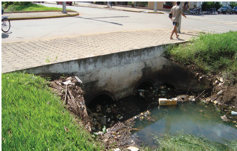
Foto 19 – Poluição ambiental – lixo nas valas de escoamento de água da chuva no centro de Sinop
