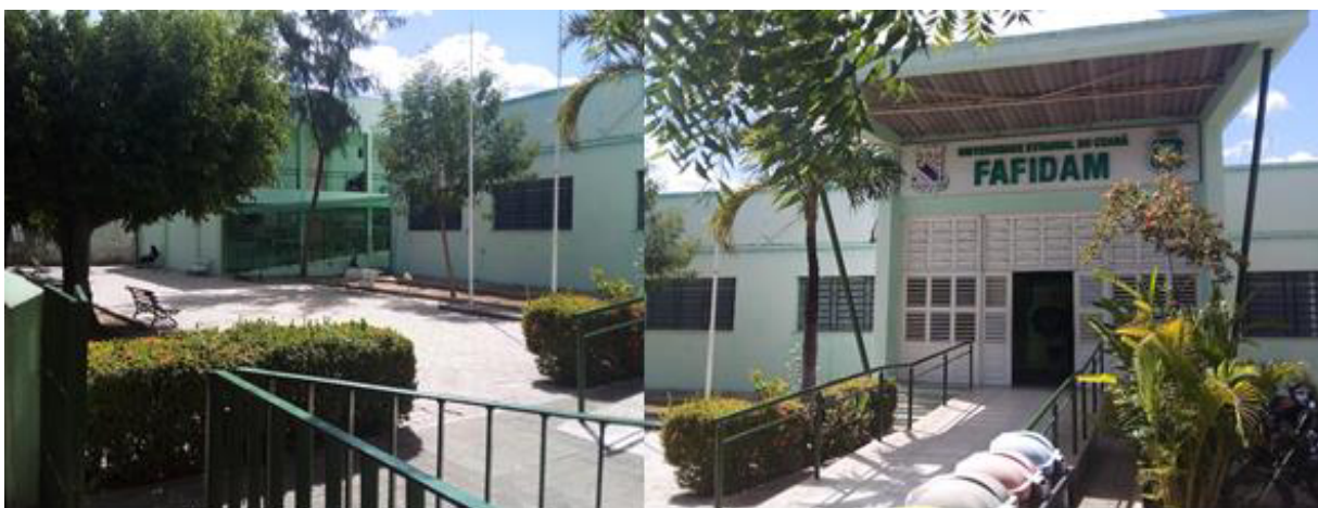
Fotografia 23 - Imagens da Entrada do Campus D
