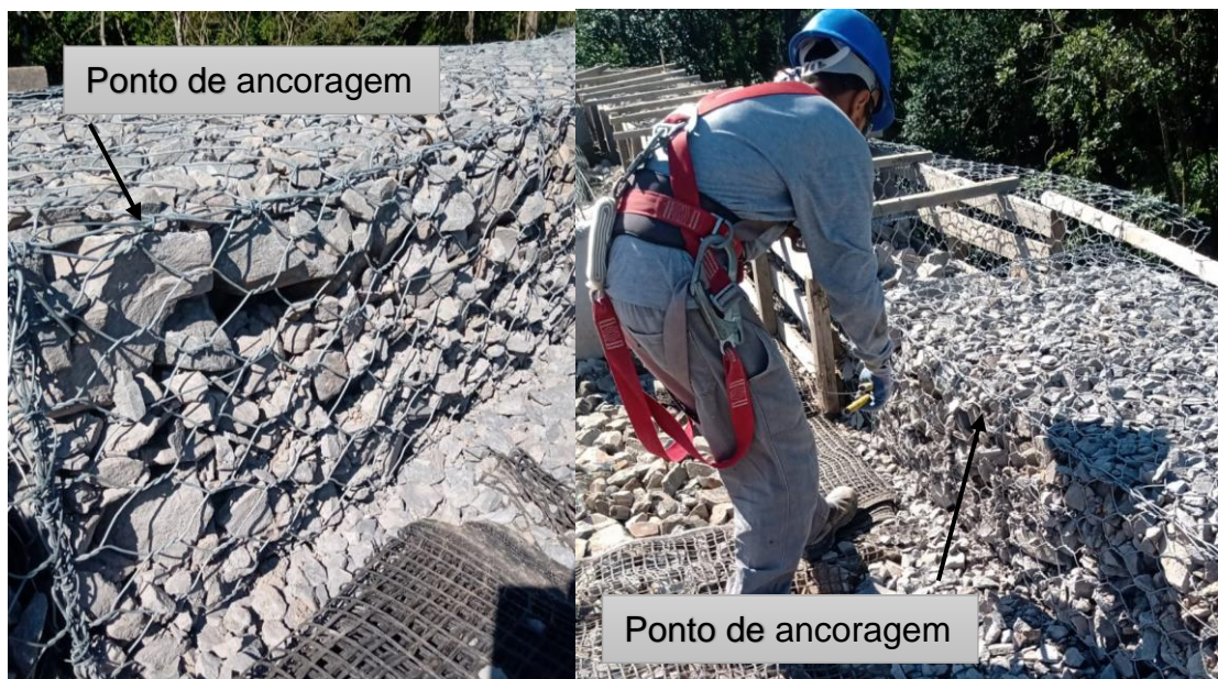
Figura 7: Pontos de ancoragem na malha do gabião
