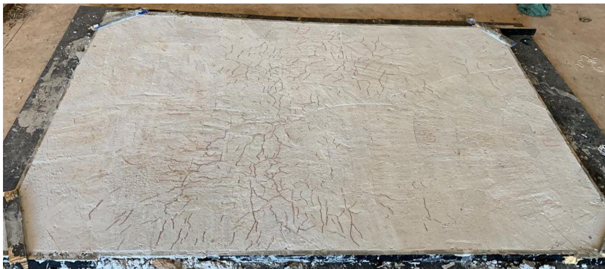
Figura 26 – Concreto referencial sem cura
