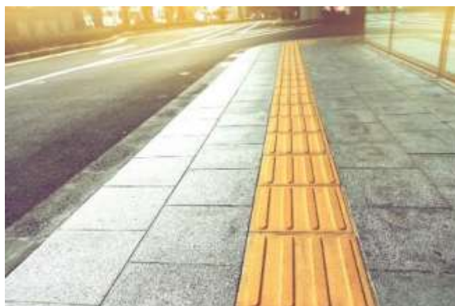
Figura 45 – Piso direcional com cor contrastante com o piso
