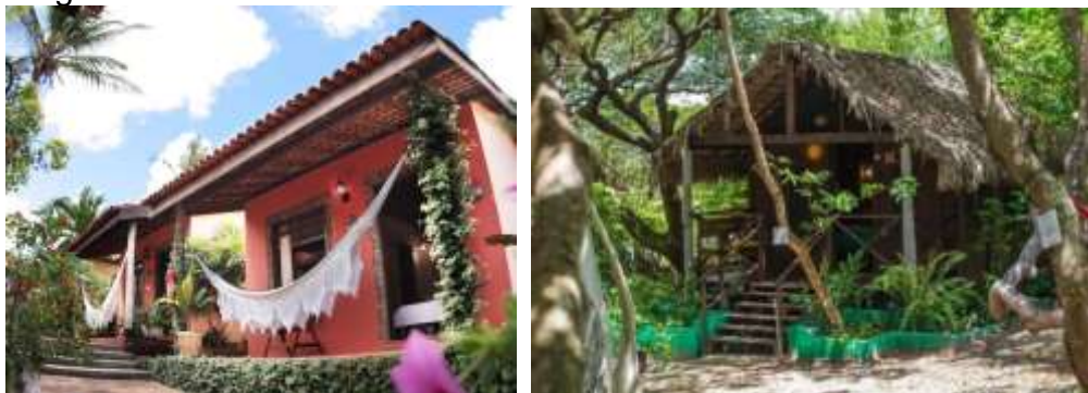
Figura 26 – Falta de acessibilidade em chalés – escadas e desníveis
