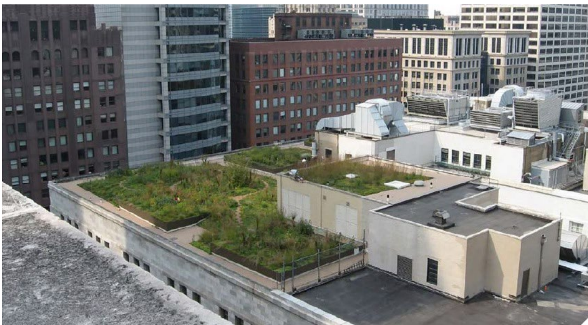
Figura 7 – Telhado verde na cidade de Chicago, EUA.
