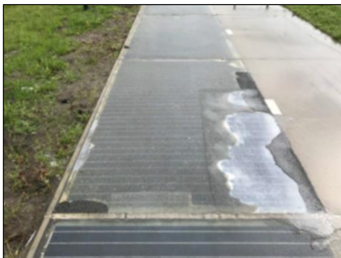
Figura 7 - Desgaste em ciclovias
