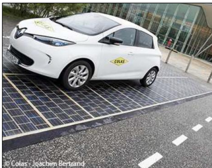
Figura 6 - Ciclovía na França com painéis Fotovoltaicos
