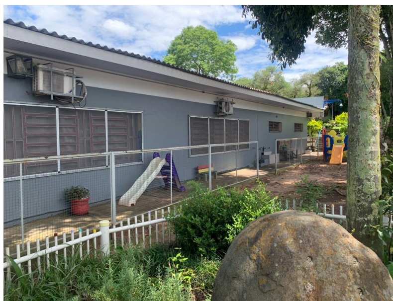
Foto 1 – Fachada da escola
