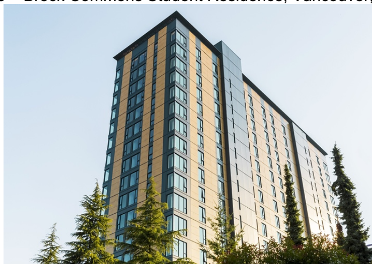
Figura 3 – Brock Commons Student Residence, Vancouver, Canadá
