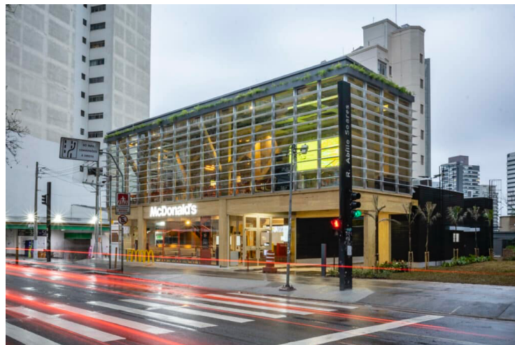
Figura 5 – Nova unidade do McDonald's construída em madeira
