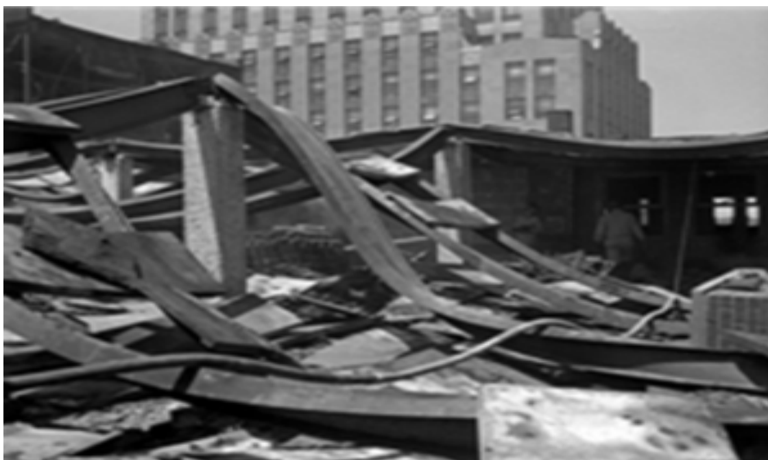
Figura 10 – Vigas e pilares de aço retorcidos em virtude da ação de incêndio
