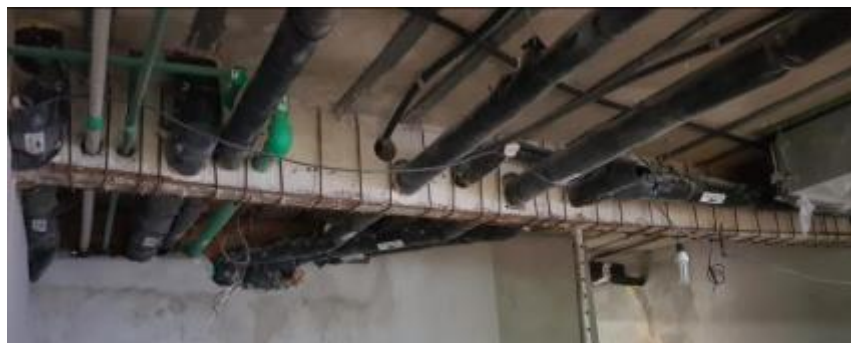
Figura 1 – Furos realizados em viga de concreto armado
