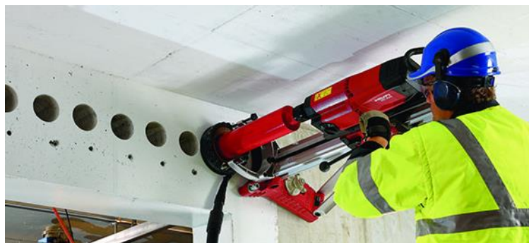
Figura 11 - Execução de furos com perfutatriz em vigas concretadas
