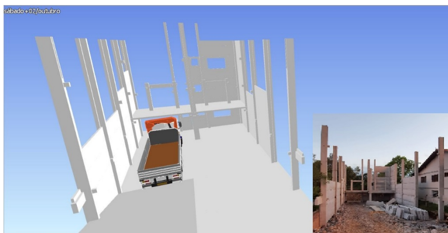
Figura 11 - Montagem Antecipada Lajes Alveolares
