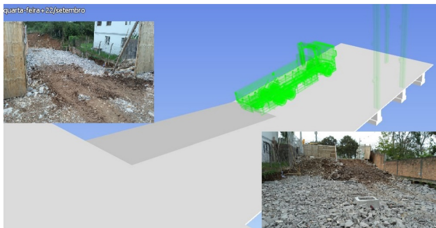
Figura 8 - Canteiro da obra
