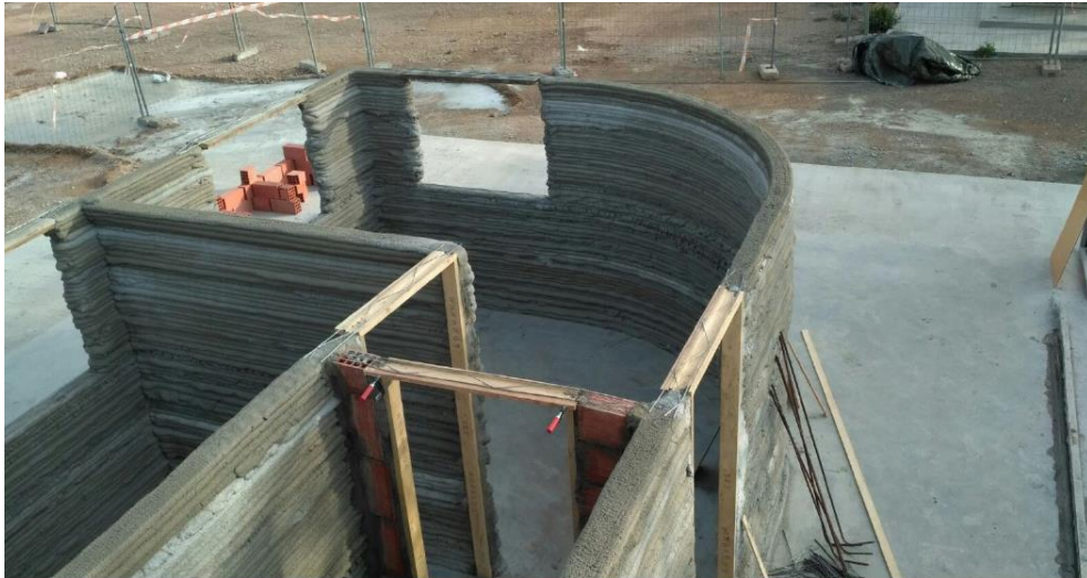
Fotografia 23 - Inserção de vergas nos vãos da 3D Housing
