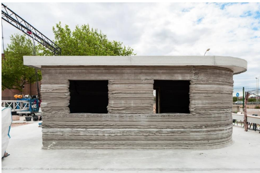
Fotografia 27 - Impressão 3D finalizada da 3D Housing
