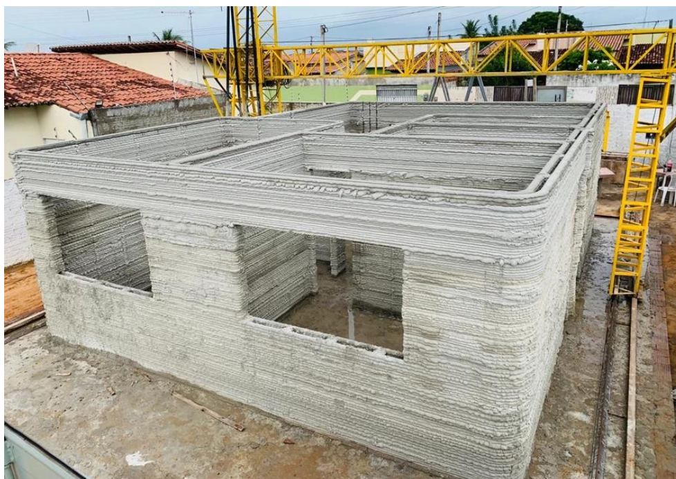
Fotografia 31 - Processo de impressão da edificação
