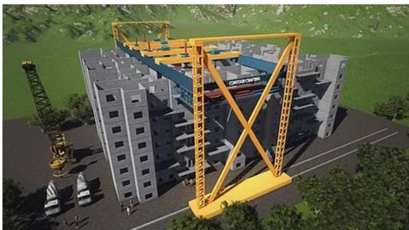
Figura 15 - Construção de grandes estruturas com várias unidades
