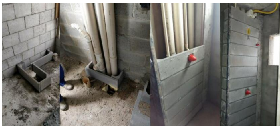
Fotografia 32 - Exemplo do processo de instalação de um shaft modular
