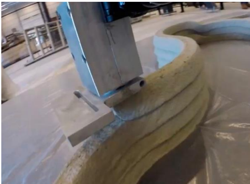
Fotografia 4 - Técnica de 3DCP em operação
