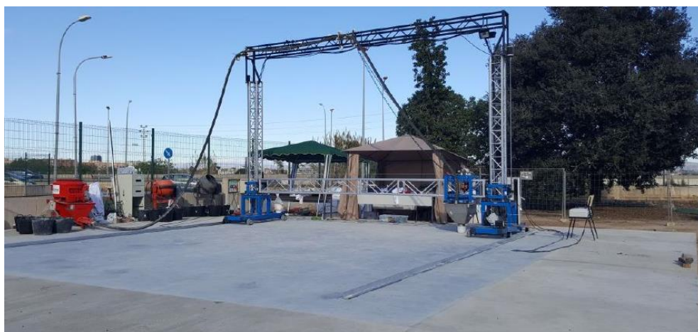
Fotografia 18 - Impressora montada no canteiro de obras
