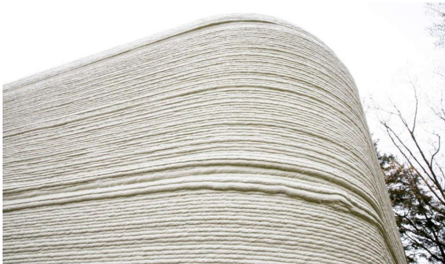
Fotografia 13 - Ponto em que se pode perceber a troca de bicos da impressora
