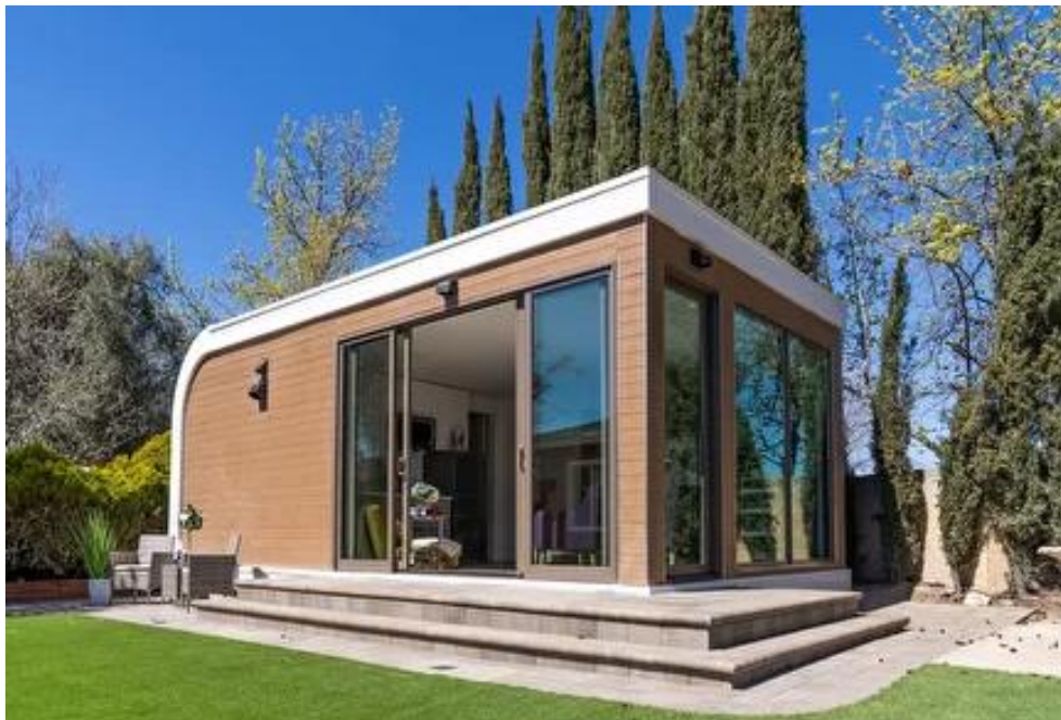
Fotografia 9 - Edificação impressa em 3D nos Estados Unidos após instalação
