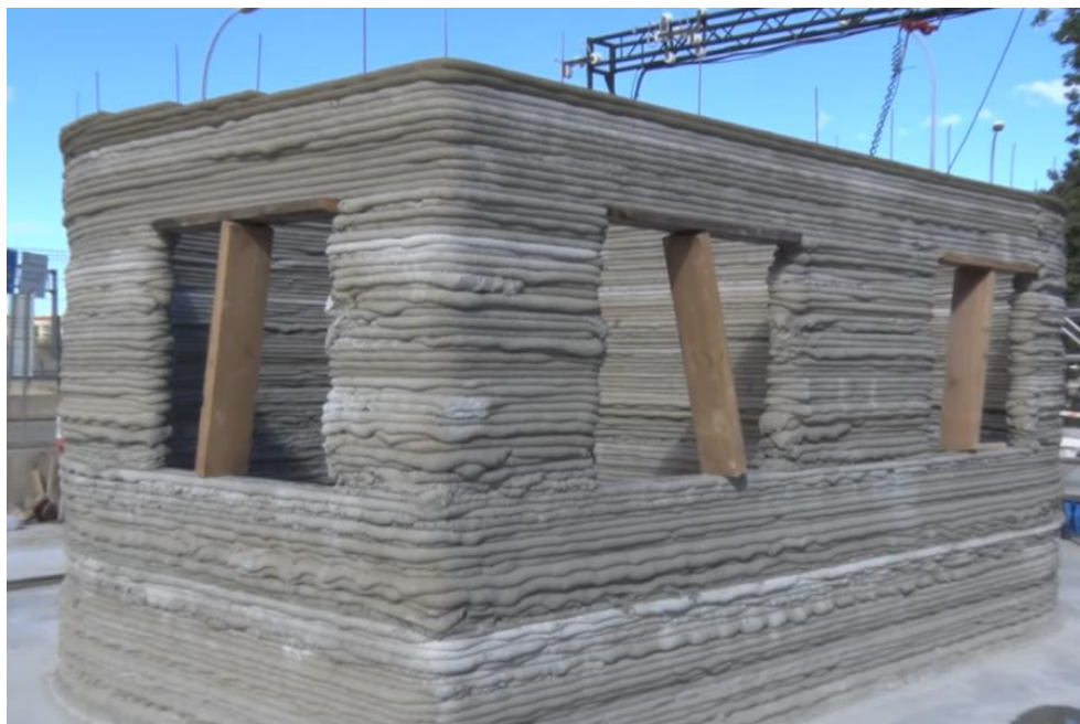
Fotografia 22 - Elementos como suporte para os vãos das esquadrias
