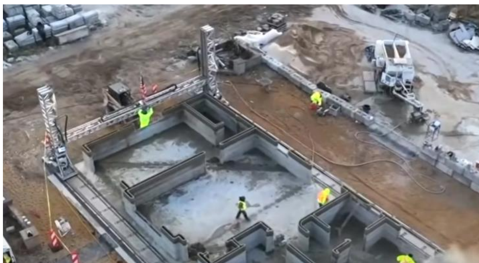
Fotografia 5 - Impressão 3D em execução nos Estados Unidos
