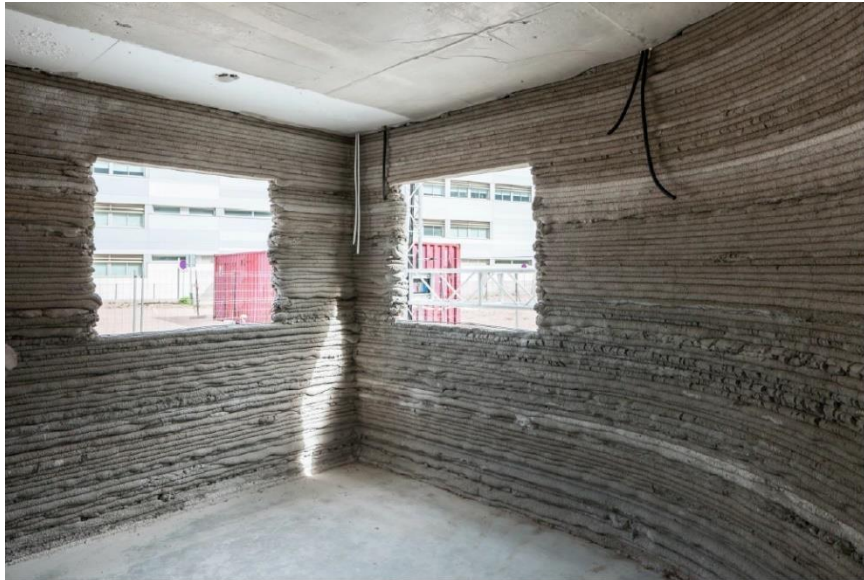
Fotografia 26 - Interior da 3D Housing com instalações aparentes
