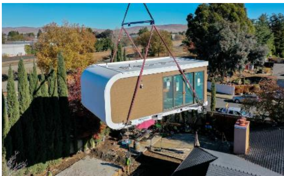
Fotografia 8 - Edificação em transporte até o canteiro de obras
