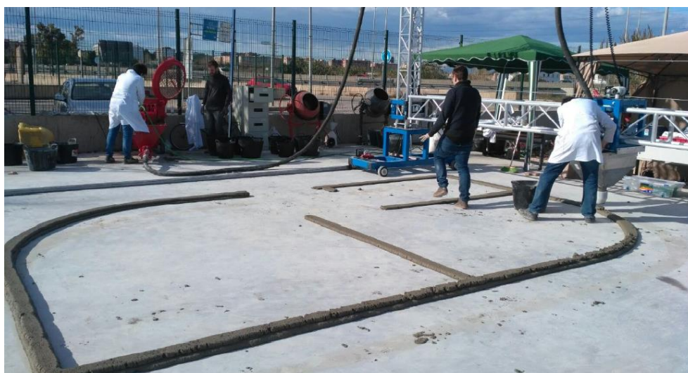
Fotografia 21 - Impressão das primeiras camadas da 3D Housing
